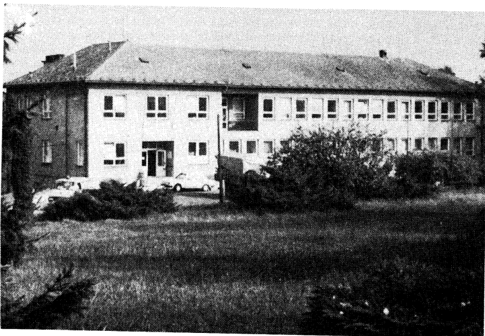
Obr. 1: Průčelí hlavní budovy Rehabilitačního ústavu v Chotěboři.
